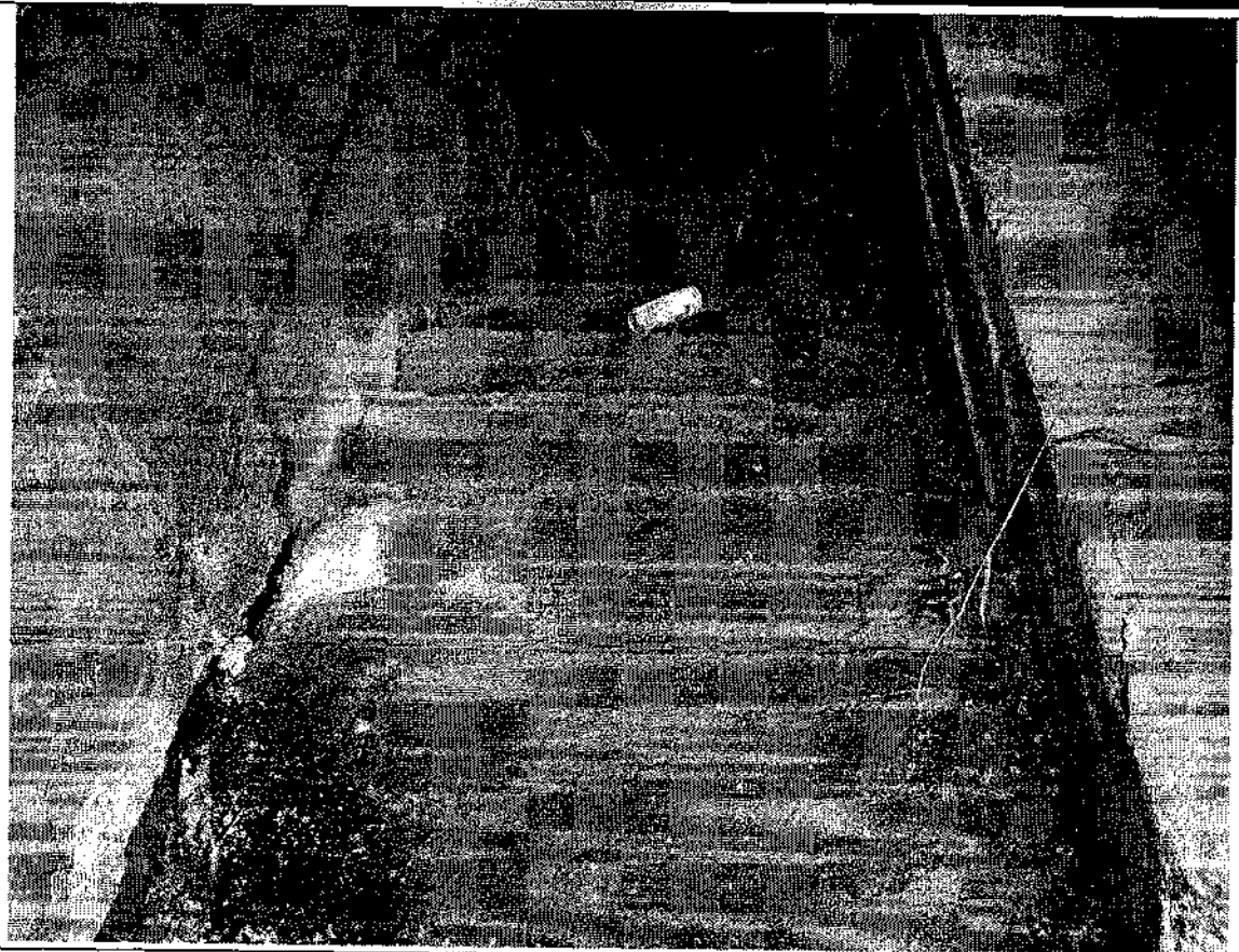
Фото 10. Лестница в подвал у 1-го подъезда. Разрушение ступеней лестницы, деформация марша.
